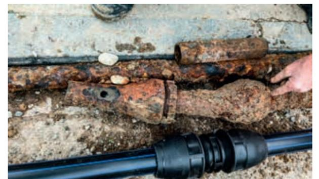
im Bild oben ausgebaute, alte Hauszuleitung im Bild unten: neue Hauszuleitung
