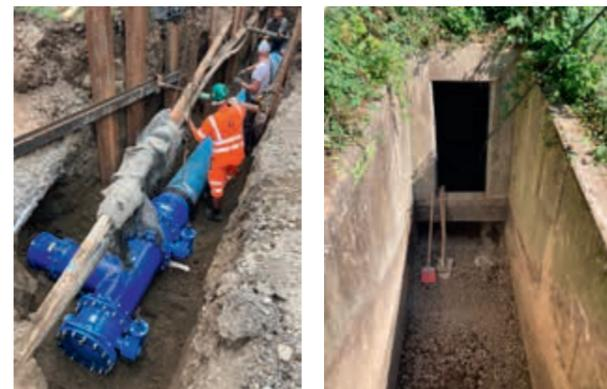
Die Leitungssanierung im Klosterweg hat Ende Juni 2022 begonnen. Dabei wird die bestehende 700 mm Kanalisationsleitung saniert, die 300 mm Wasserleitung ersetzt, der Regenwasserkanal 630 mm, die Strasse und die Kande-laber neu erstellt.
