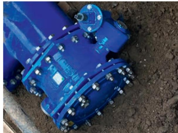
Der Blindflansch am T-Stück dient bereits als Vorbereitung, das Wassernetz der Gemeinde Unteregstringen durch das neue Grundwasserpumpwerk Zelgli von Schlieren her zu erschliessen. Die neue Leitung aus Schlieren wird im Spülbohrverfahren unter der Limmat gebohrt.
