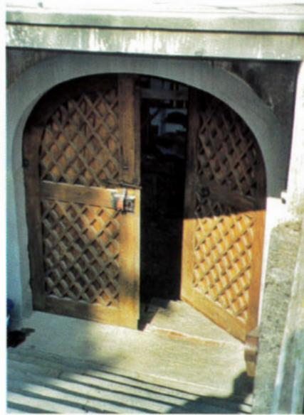
Interessante Türkonstruktion zum Keller des Konventgebäudes. Es lassen sich nicht nur die zwei Türflügel öffnen, sondern in jedem Türflügel hinter dem Holzgitter zwei Halbflügel. Dies erlaubt eine fein dosierte Kellerlüftung.
