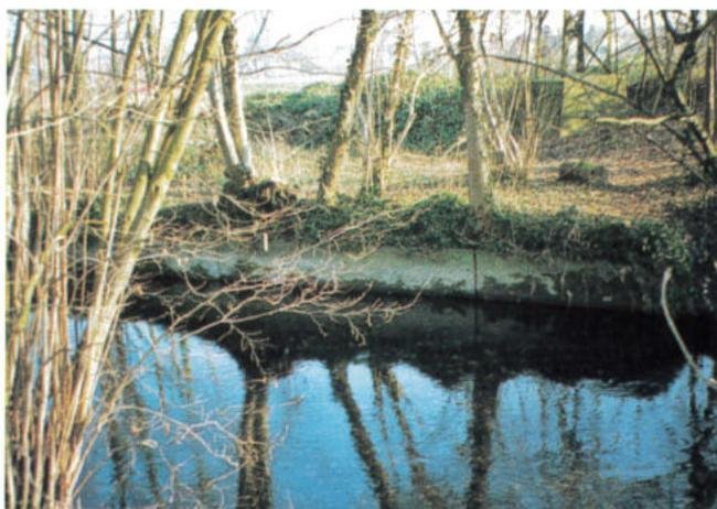
Der Oberlauf des Mühlekanals war an beiden Ufern mit riesigen Steinplatten ausgekleidet.
