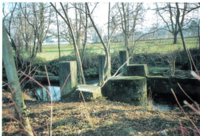
Reste der Schleuse an der Abzweigung des «äusseren Giessens» vom Mühlekanal. Mit dieser Schleuse konnte die Wasserzufuhr zu den Wasserrädern des Klosters reguliert werden.
