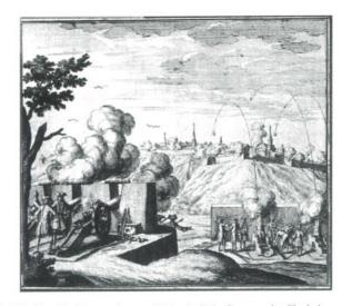
Das Neujahrsblatt der Feuerwerker von 1727 zeigt links die gestreckte Flugbahn der Kanonen und rechts den Bogenwurf der Mörser.
